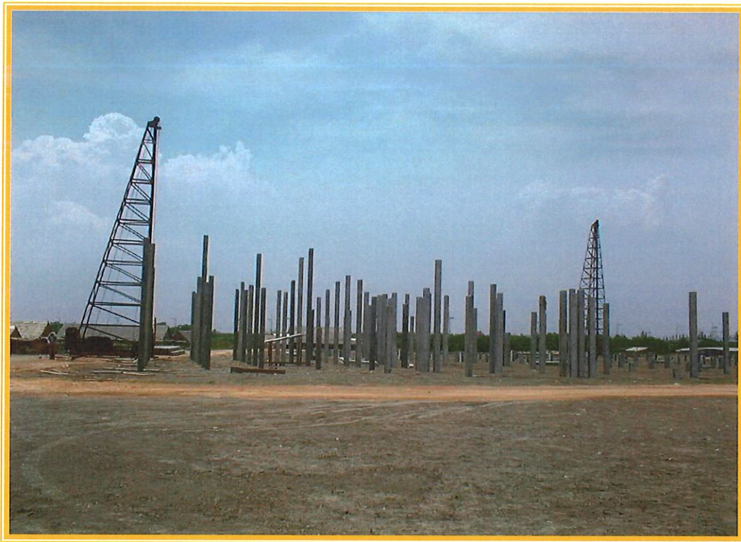
โครงการก่อสร้างอาคาร โรงงานผลิตถ่านร็อคคอฟเวอร์ จำกัด พระราม 2 มหาชัย สมุทรสาคร
