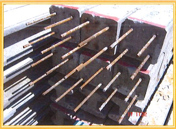
เสาเข็มรูปสี่เหลี่ยมมี DOWEL BAR ออกมาด้านนอก
