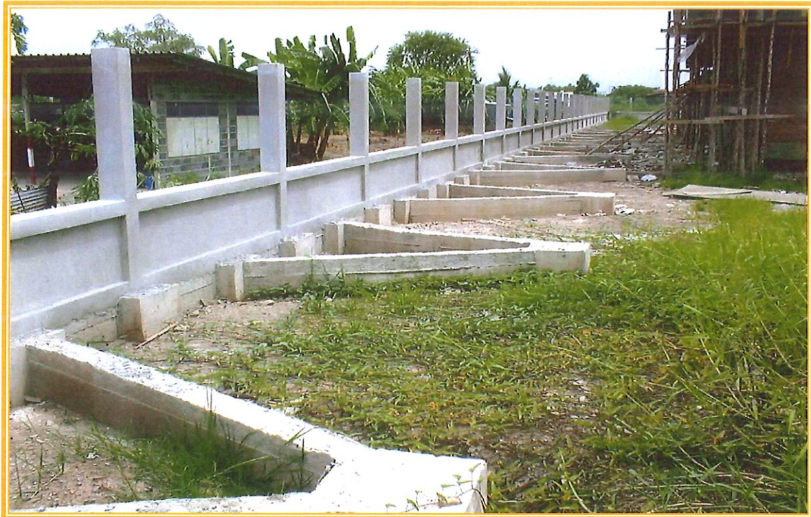
โครงการก่อสร้างกำแพงกันดิน สถานีอนามัยเขตคลองสามวา กรุงเทพฯ
