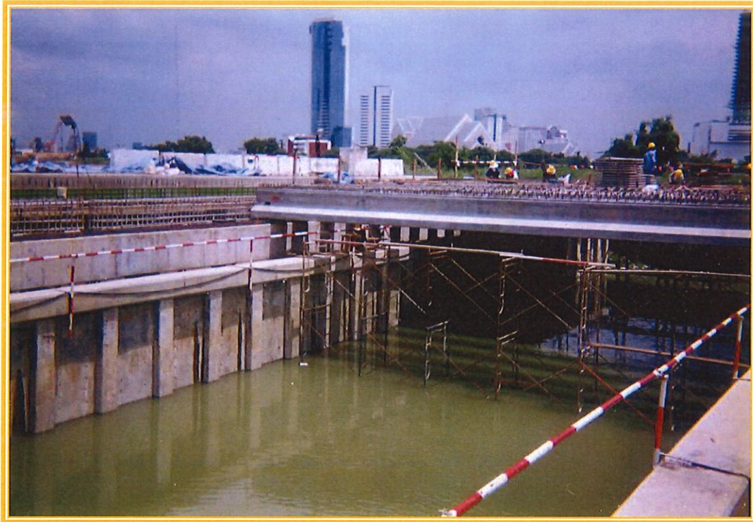
โครงการก่อสร้างกำแพงกันดิน ในโครงการ รฟม. (MRTA) ถนนพระราม 9 (เทียมร่วมมิตร) กรุงเทพฯ
