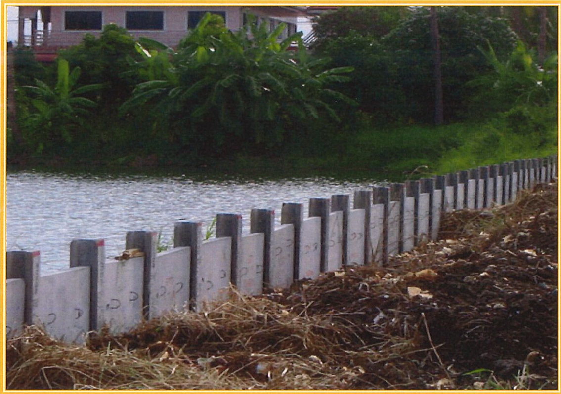
ก่อสร้างกำแพงกันดิน ยาว 1 กม. โครงการหมู่บ้าน กฤษदानนคร 48 โชน ซี่ ถนนสุขาภิบาล 2 กรุงเทพฯ
