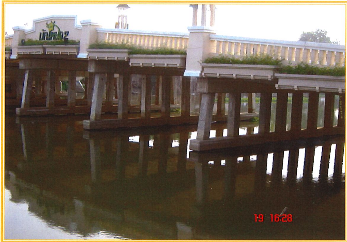
โครงการก่อสร้างสะพานข้ามคลอง หมู่บ้านมักเทศา 2 รังสิต คลอง 3 จ.ปทุมธานี
