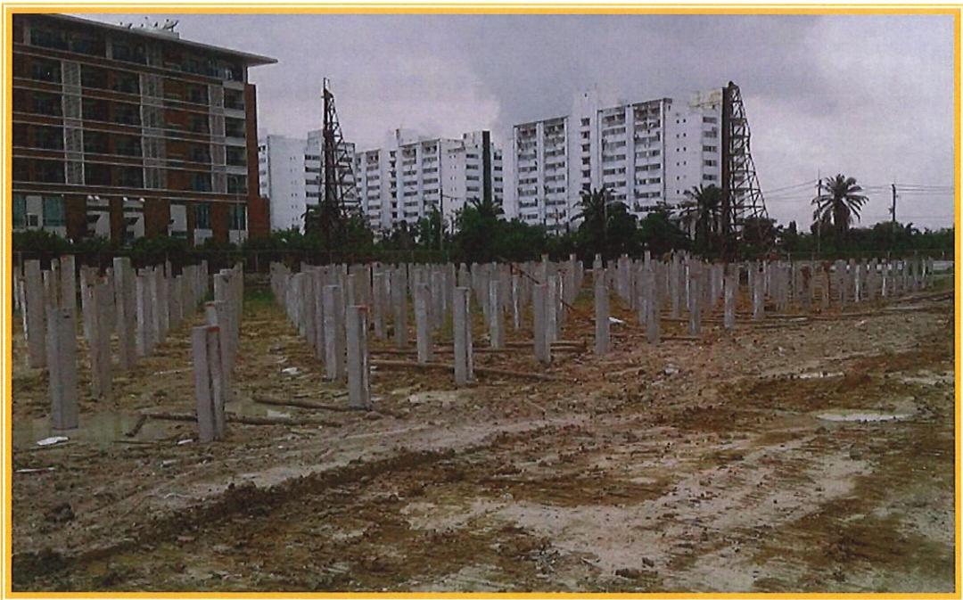
โครงการก่อสร้างลานเก็บตู้คอนเทนเนอร์ วัดศรีวารีน้อย
