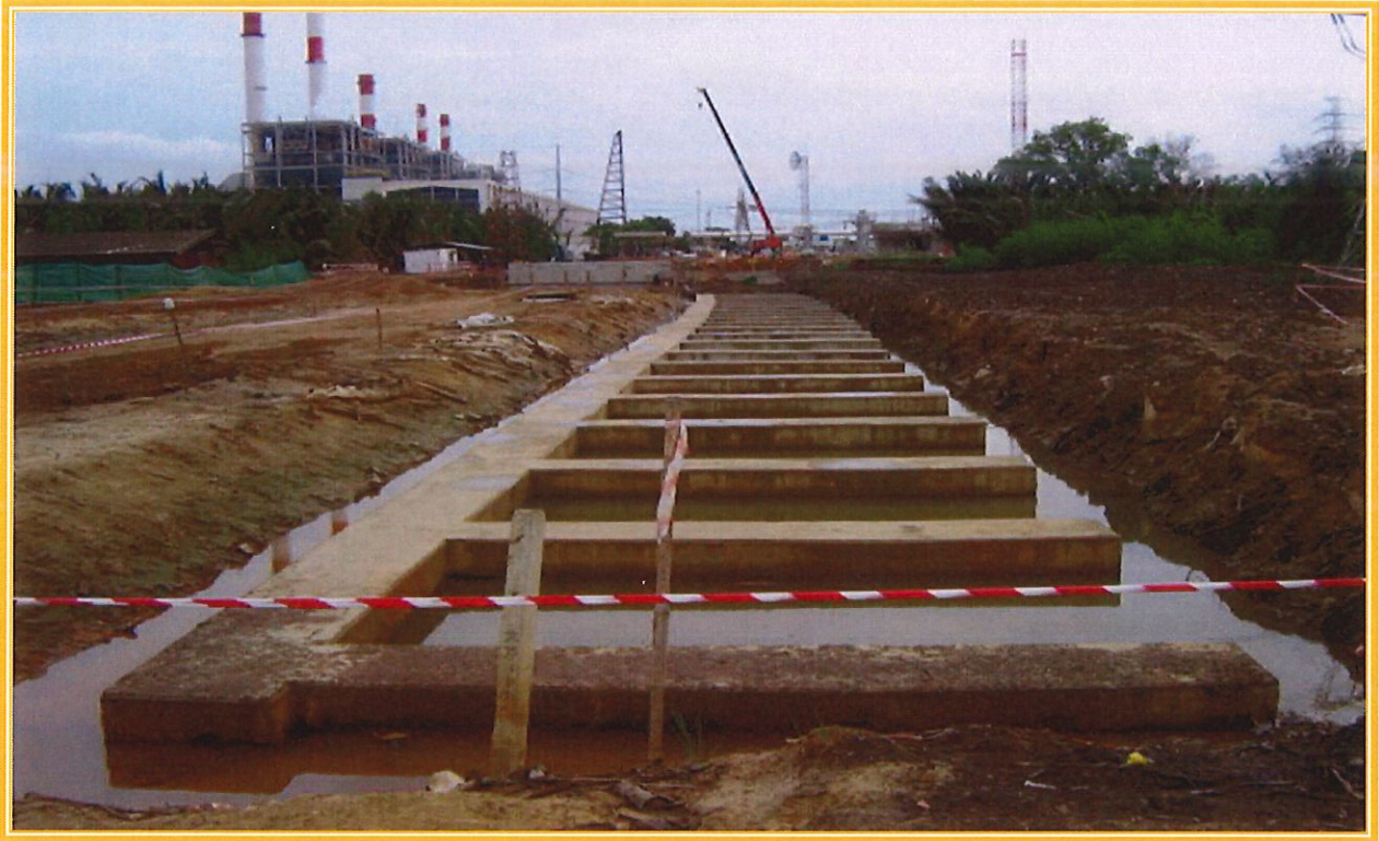
โครงการก่อสร้าง PIPE PROTECTION WITH TIED 150M. (SBMR) โรงไฟฟ้าพระนครใต้ ต.ปู่เจ้าสมิงพราย จ.สมุทรปราการ
