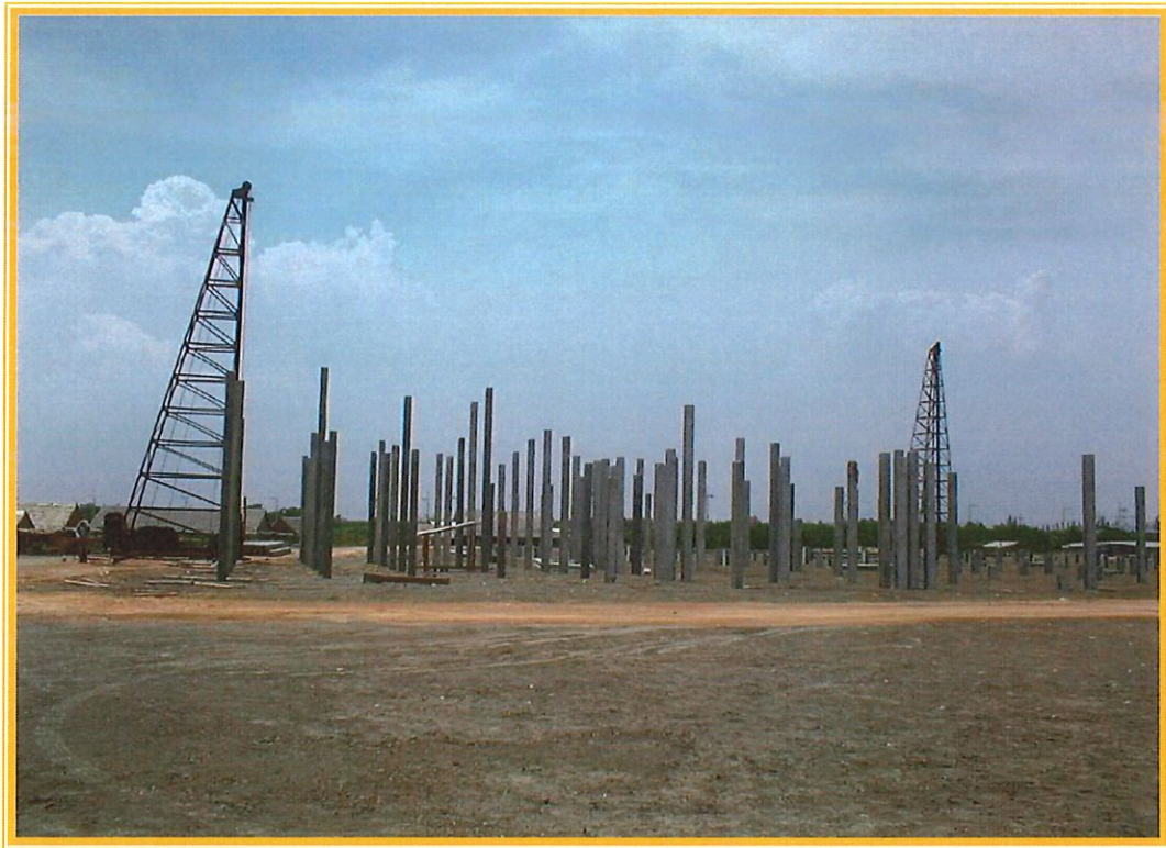
โครงการก่อสร้างอาคาร โรงงานเอ็กตราพรีคอสโพลเวอร์ จำกัด พระราม 2 มหาชัย สมุทรสาคร
