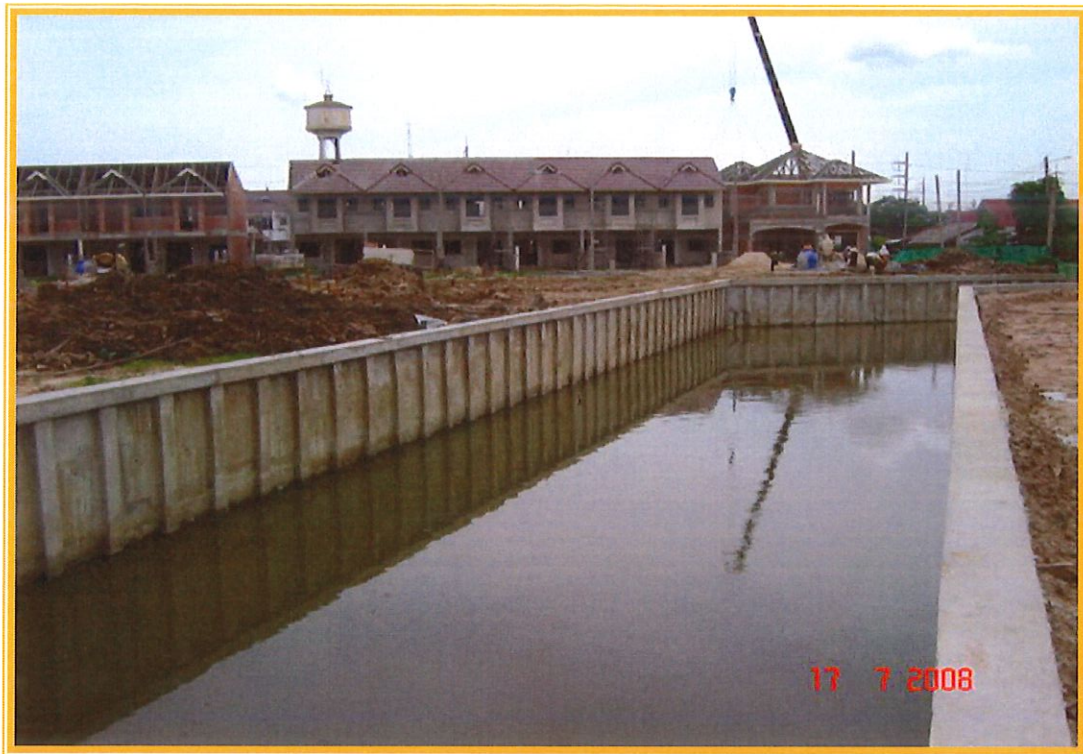
โครงการก่อสร้างเขื่อนกันดิน ค.ส.ล. ริมคลองห้วยอีแหก (บริเวณเว็ดใหม่)
