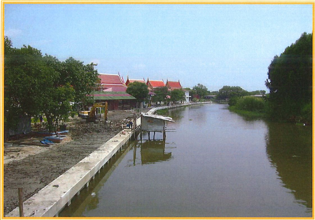
ก่อสร้างเขื่อน ค.ส.ล. ป้องกันตลิ่งพังริมคลอง บริเวณวัดบางโจลง หมู่ 1 ต.บางโจลง อ.บางพลี จ.สมุทรปราการ
